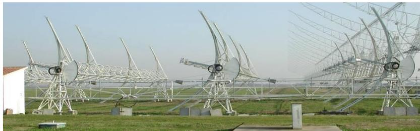
L'asse di rotazione della singola antenna N/S è posto in direzione Est/Ovest, consentendo la sola rotazione del cilindro parabolico lungo il senso Nord/Sud. Lo specchio dell'antenna è formato da una serie di fili metallici di 0,5 mm di diametro, posti parallelamente uno all'altro ad una distanza di 20 mm.
