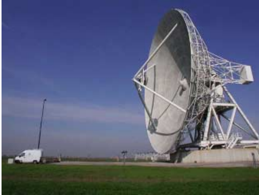
Figura 2.3 Horn a 11 m. di quota, nel pieno Beam dell'Antenna Parabolica
