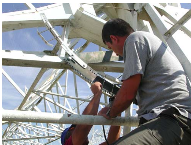
Fig.21 Regolazione primo finecorsa
