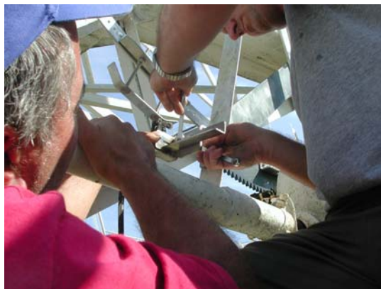
Fig.19 Montaggio e posizionamento switch su antenna
