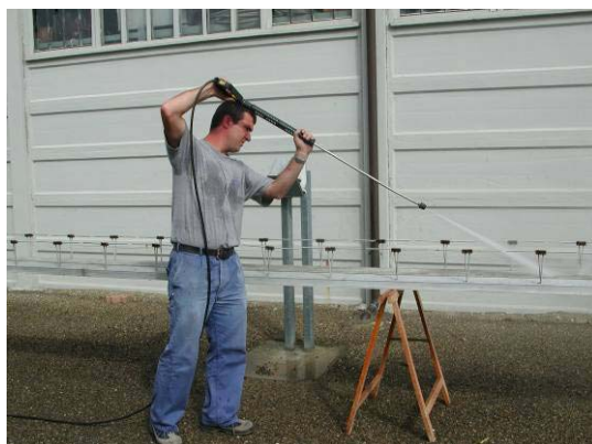
Fig.2-03 Pulizia linee focali
