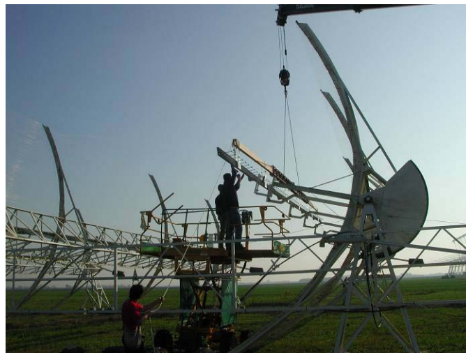
Fig.3-08 Posizionamento provvisorio linea focale
