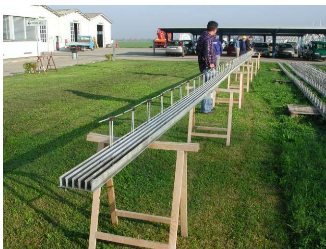
Fig.3-04 Posizionamento linea su cavalletti
