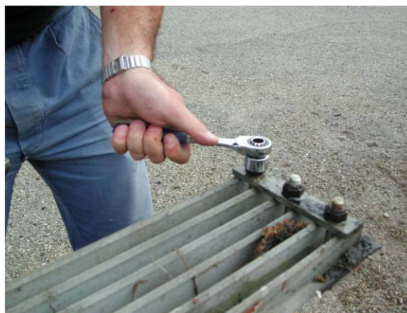
Fig.2-02 Rimozione piastre esterne
