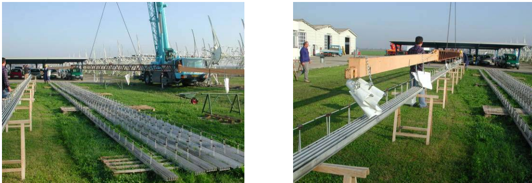
Fig.3-05 Preparazione e posizionamento trave tutore
