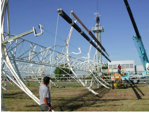
Fig.1-06 Posa linee focali a terra
