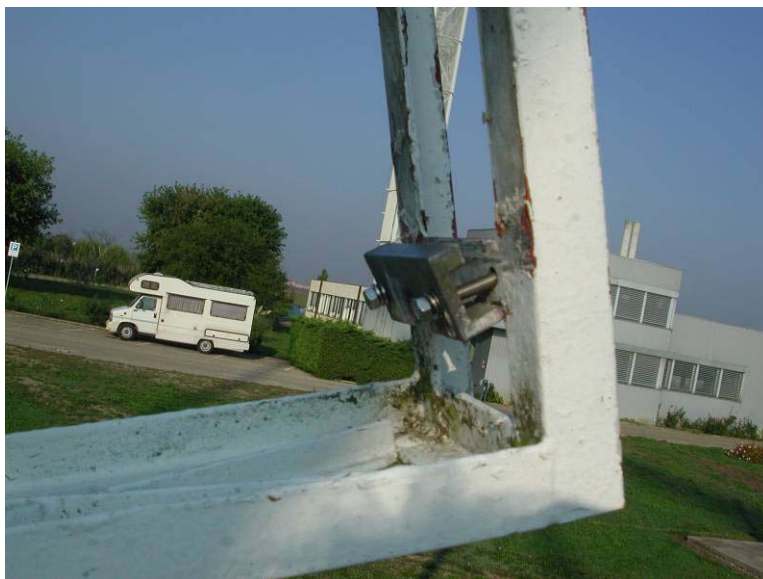
Fig.3-03 Posizionamento morsetti
