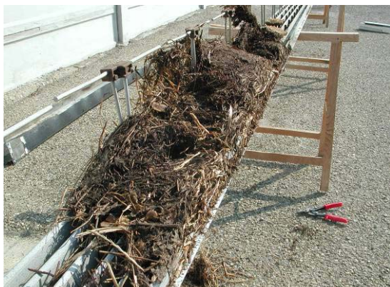
Fig.2-03 Pulizia linee focali
