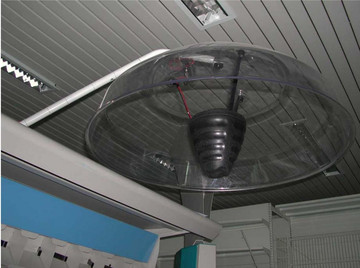
Figura 9: Campana ipercardiode in plexiglass per la diffusione dell'audio in una zona limitata.
