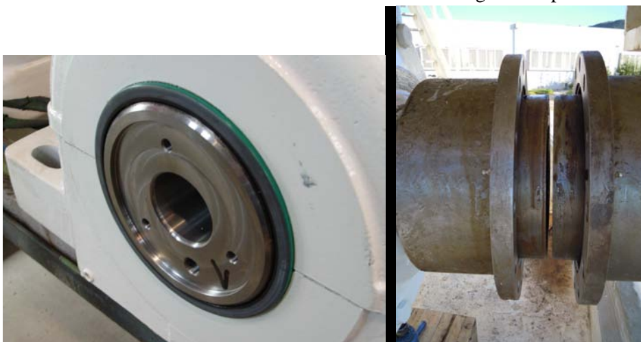
fig. 10 Allineamento supporti e riduttori
