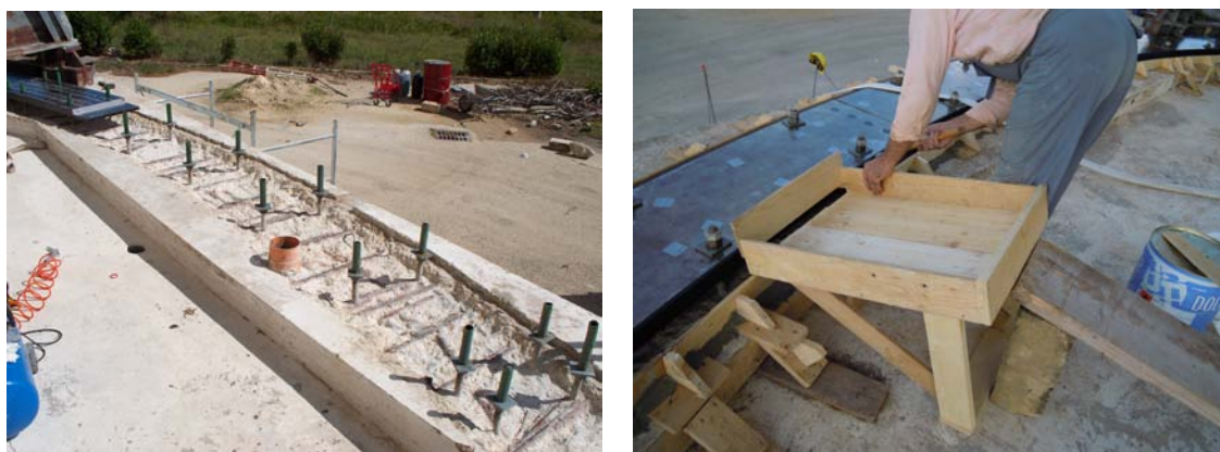
Fig. 7- Pulizia tirafondi, tramogge per il getto.
