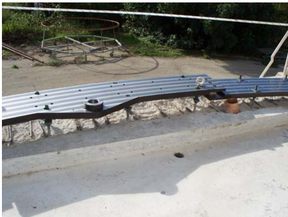
Fig. 6- Posa ed allineamento piastre
