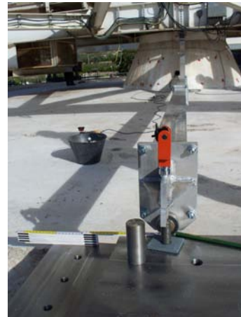
Fig. 6- Posa ed allineamento piastre
