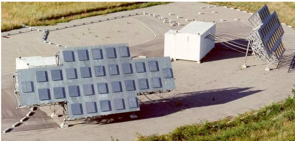
Fig. 11 – Due delle antenne trasmettenti del radar GRAVES
