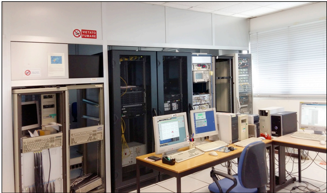
Figura 13 - La sala controllo così come è stata allestita ad agosto 2016.
