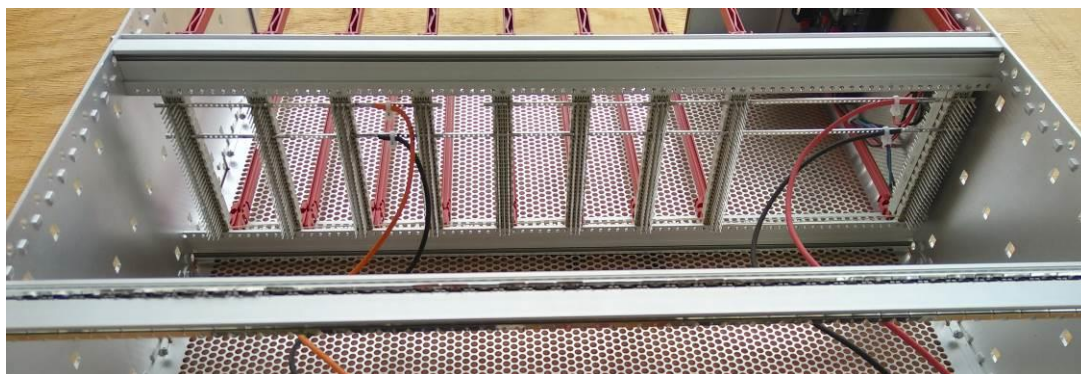
Figura 26 – Cablaggio pannello posteriore
