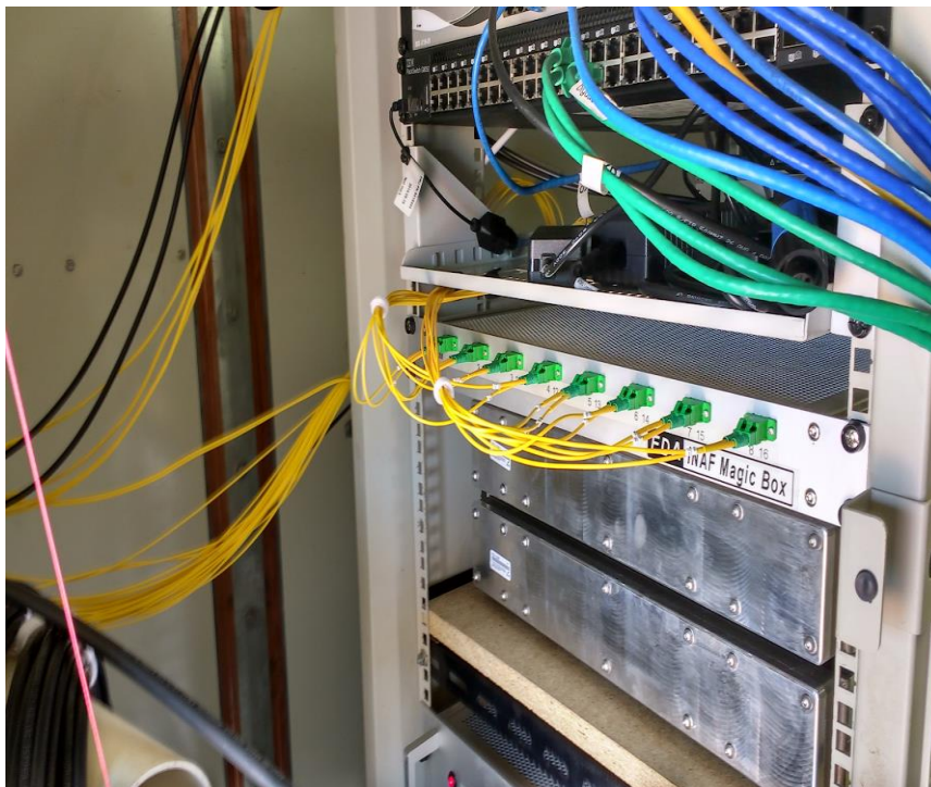
Figura 28 – Installazione del Box
